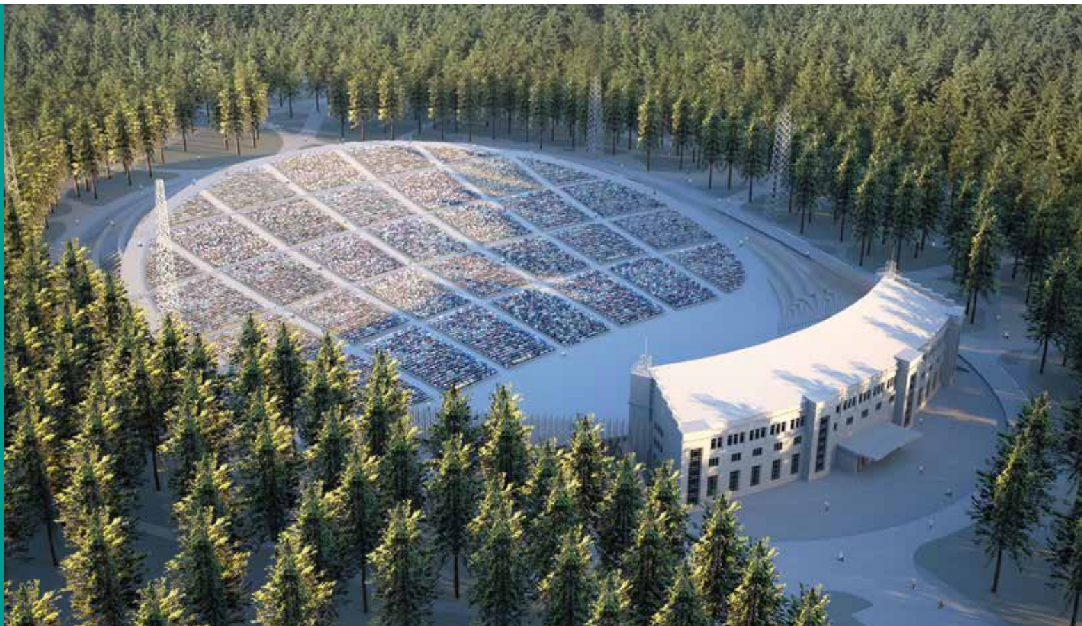
Mežaparka Lielās estrādes pārbūve. Būvuzņēmējs – PS LNK, RERE
