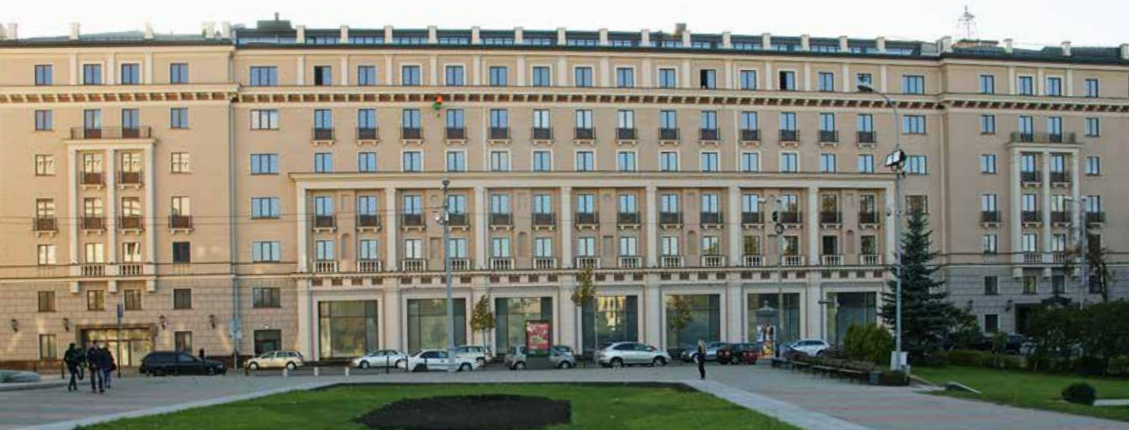
Viesnīcas Grand Hotel Kempinski Riga rekonstrukcija. Būvuzņēmējs – SIA Abora
