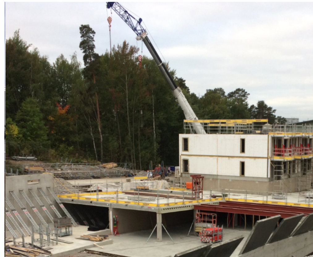
Monolītā betona konstrukcijas
